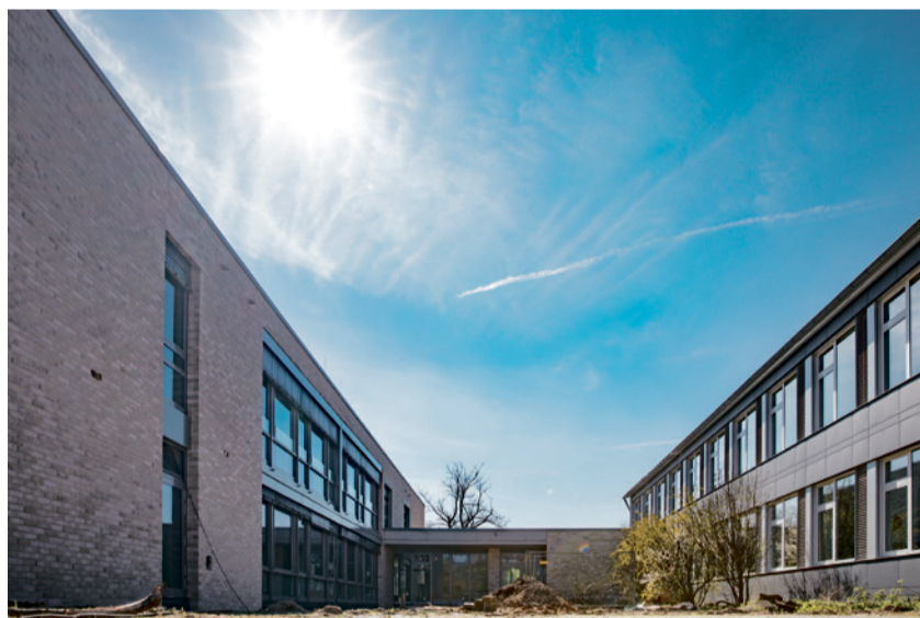
Der Erweiterungsbau der Görresschule ist bald fertig und über die Eingangshalle mit dem Bestandsbau verbunden.
