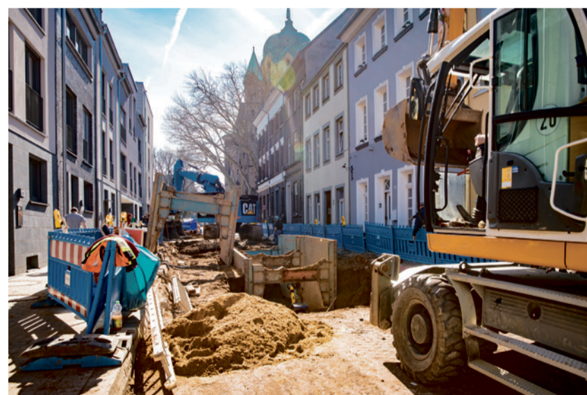
Aktuell wird unter anderem an den Kanälen in der Quirinusstraße gearbeitet.
